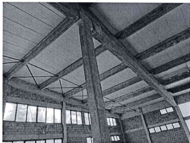
Фотографија 8. Кровна конструкција
